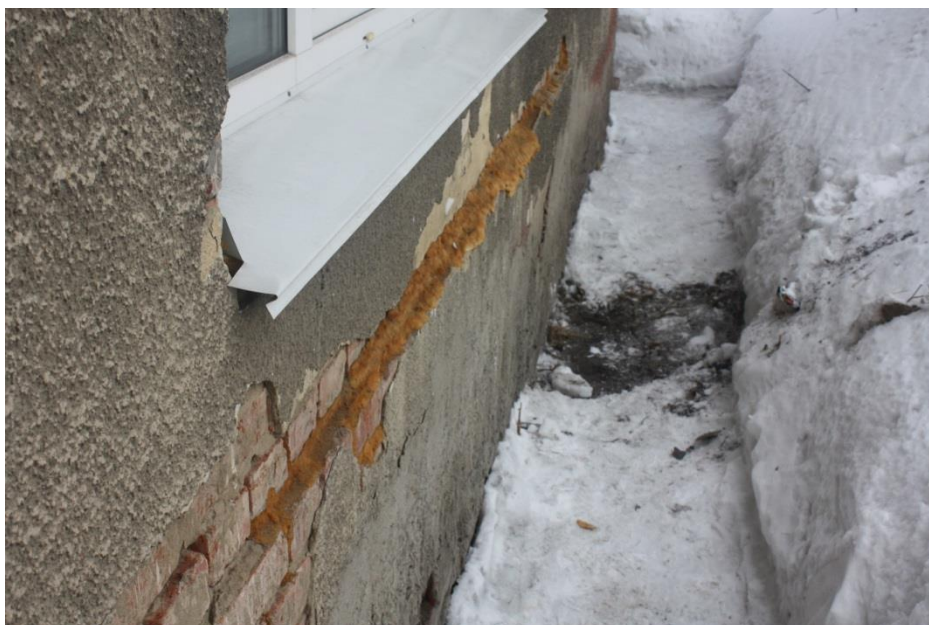
Рисунок 7.25 – Выпучивание стены.
