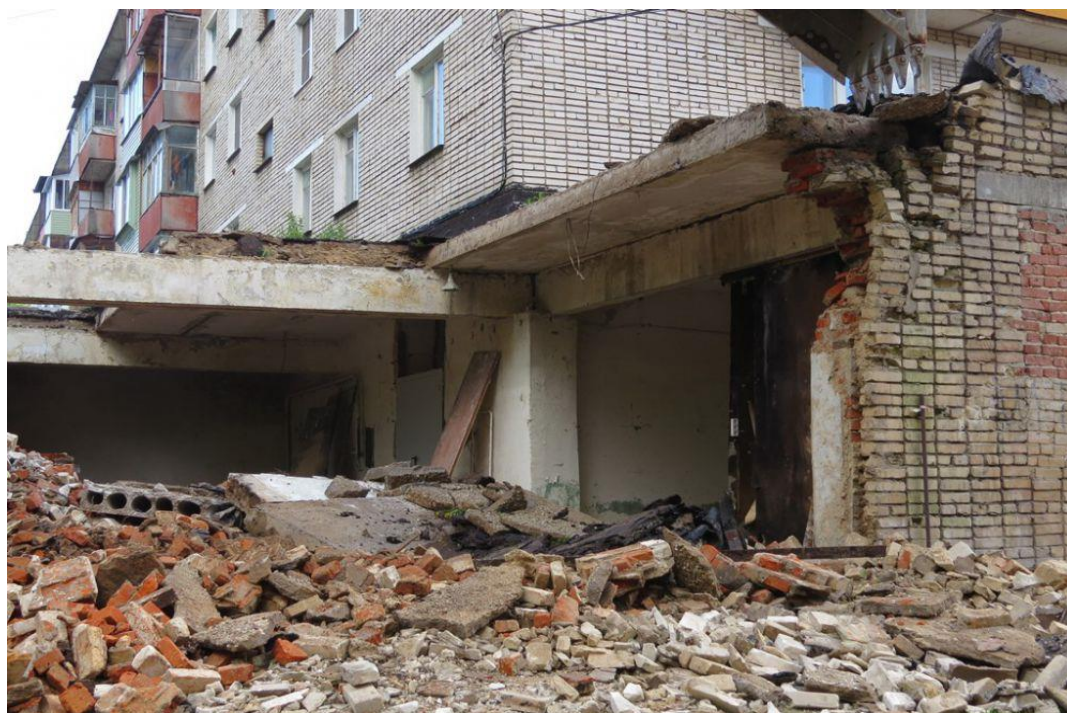
Рисунок .3 г – Место демонтажа двухэтажной железобетонной пристройки нежилого назначения к кирпичному пятиэтажному зданию.
