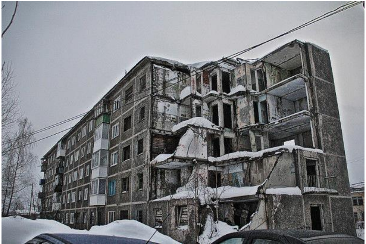
Рисунок 7.2 – Физическое отсутствие наружных и внутренних простенков.
