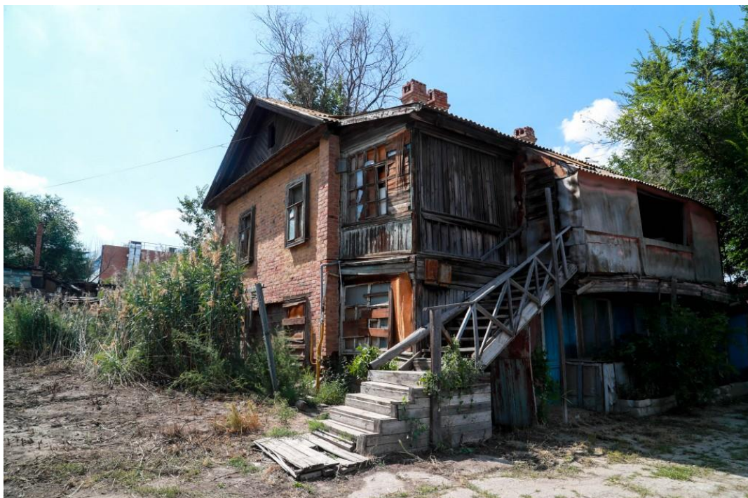
Рисунок 8.3в – Деревянная пристройка жилого назначения с устройством отдельного входа через наружную галерею к двухэтажному кирпичному зданию
