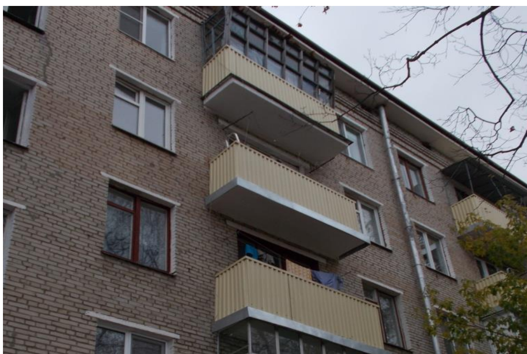
Рисунок 8.2 – Жилое пятиэтажное здание с капитальным ремонтом балконов: г. Москва, ул. Нарвская, 4.
