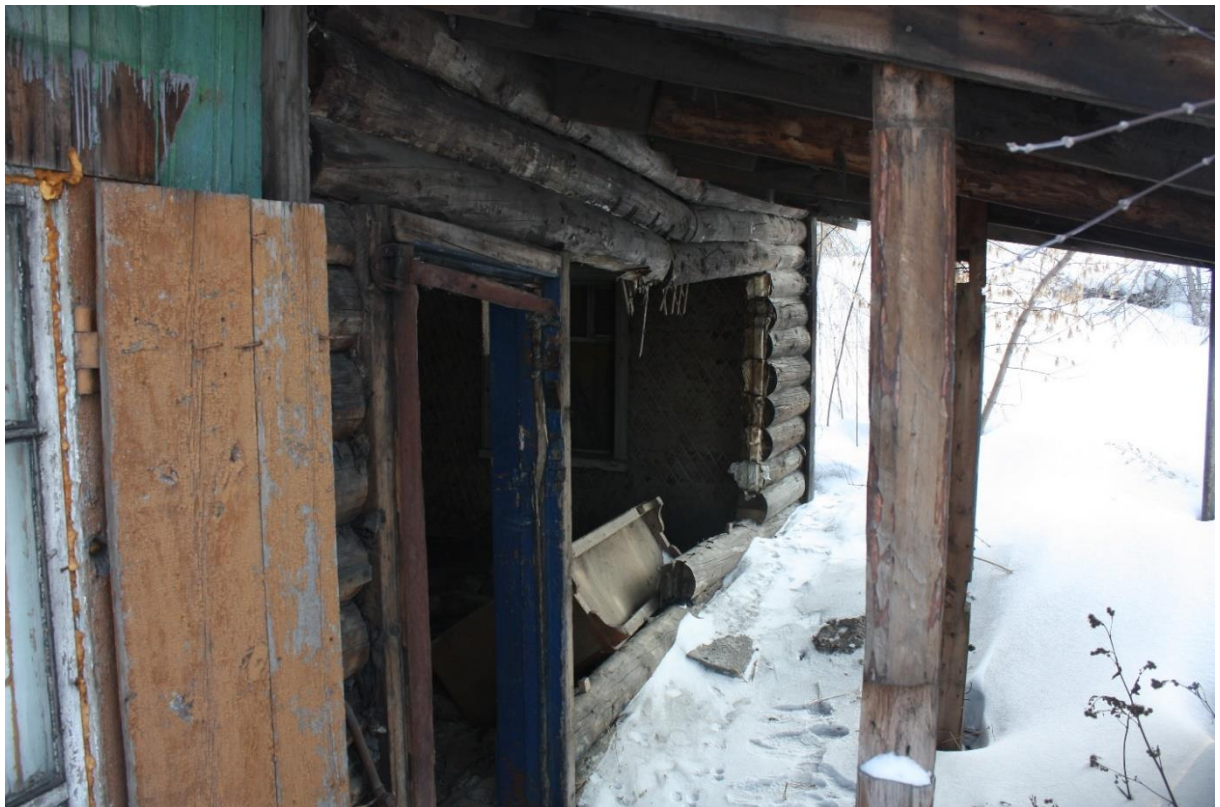
Рисунок 7.3 – Физическое отсутствие наружного простенка.
