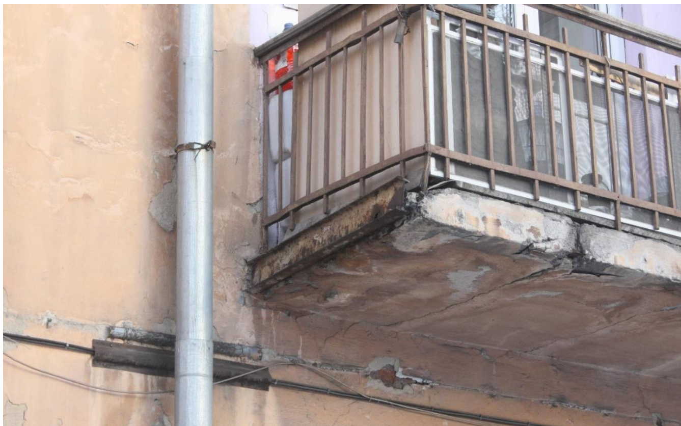
Рисунок 7.44 – Уклон железобетонной балконной плиты.
