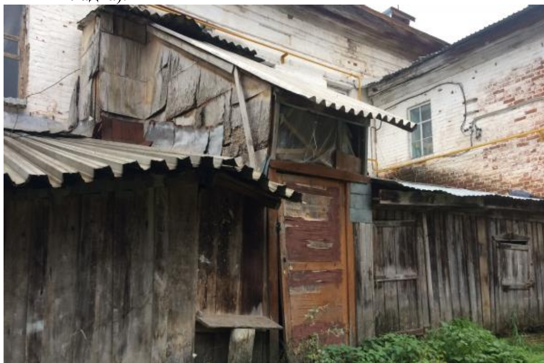
Рисунок 8.3б – Деревянная пристройка хозяйственного назначения к кирпичному двухэтажному жилому зданию.
